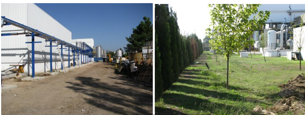
Figura 55 – Vista geral do terreno (solo urbano)
