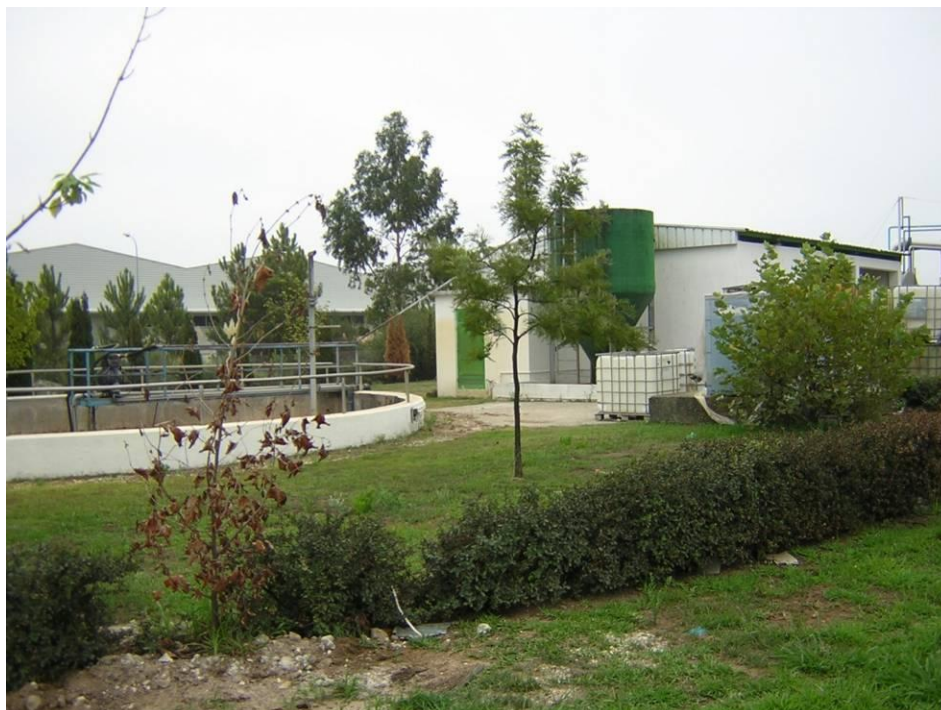
Figura 45 – Aspecto geral na zona da ETAR e zona ajardinada adjacente
