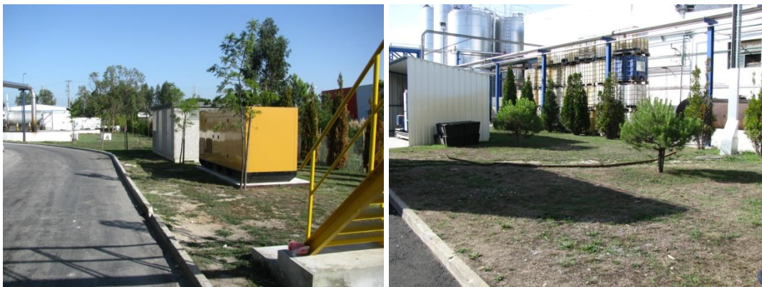
Figura 54 – Vista geral do terreno (solo urbano)
