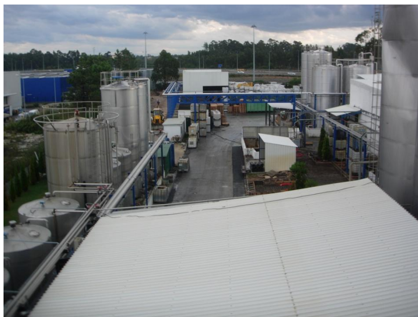
Figura 35 – Aspecto geomorfológico da área de intervenção
